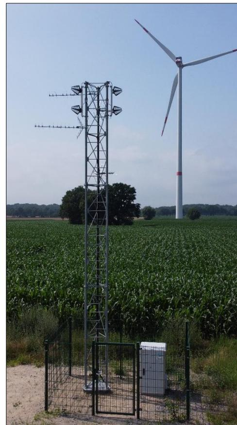
Ilustración 4: Antenas receptoras de señales implementadas en torre
